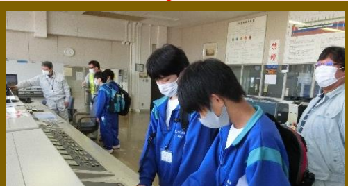
阿武隈大堰の操作室見学
