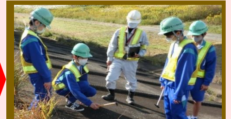
コンクリートを叩いて空洞を確認中♪
