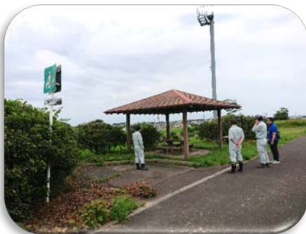
▲左岸サイクリング・散歩道路休憩所(岩沼)
