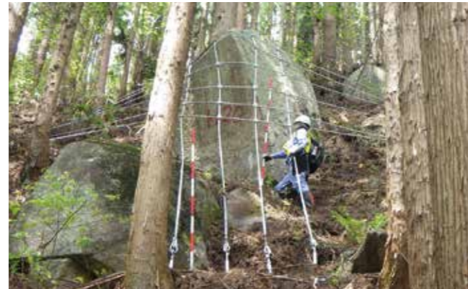
対策(ロープ掛け)後の点検
