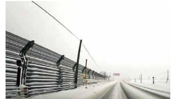
対策(防雪柵設置)後の点検
