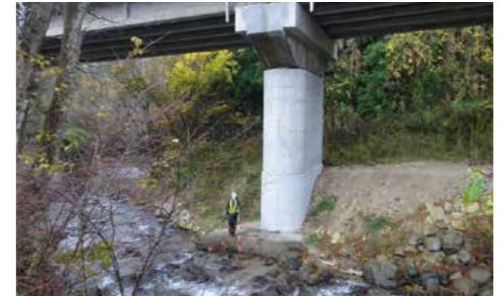
橋脚基礎洗掘の点検
