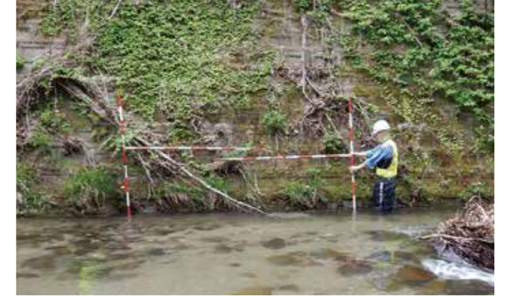
擁壁(護岸)の点検
