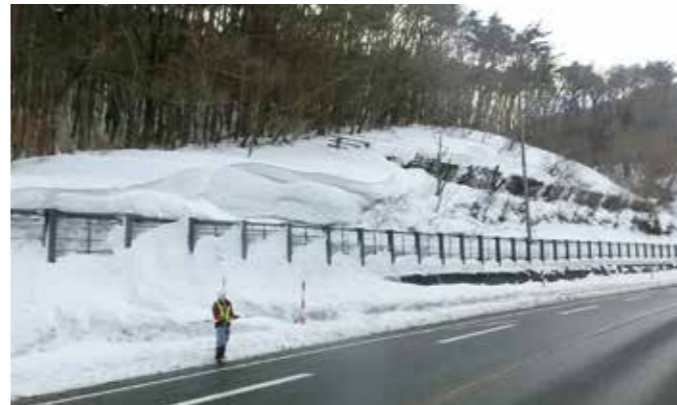
雪庇発生状況の点検
