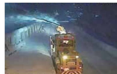
集中除雪作業の状況
