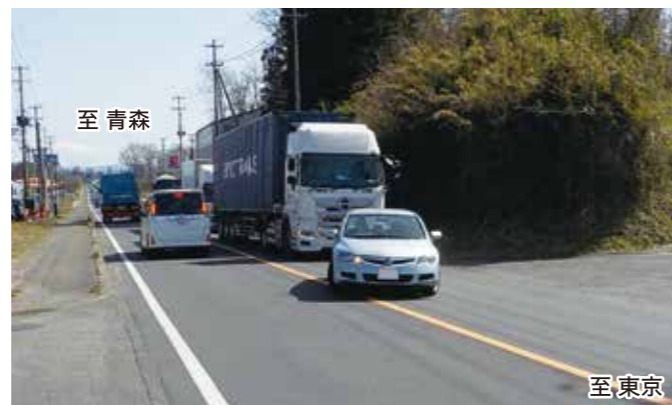
右折レーン未整備箇所(北浦交差点)
