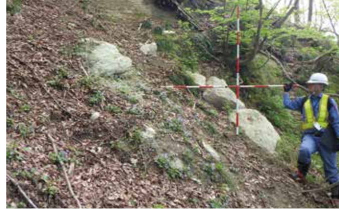
法面(転石・浮き石)の点検
