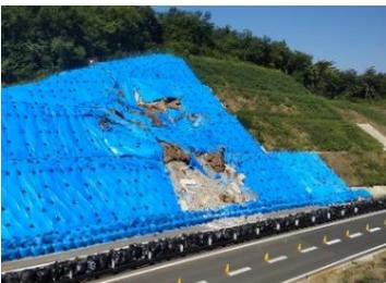
写真② 法面の孕みだし
