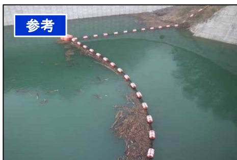
<洪水等によりダムに流木が流れ着く状況>
