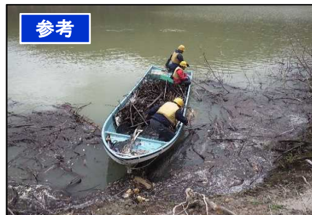
<洪水等によりダムに流木が流れ着く状況>
