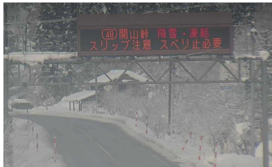
▲道路情報板によるチェーン装着等の周知 (国道48号作並道路情報板)
