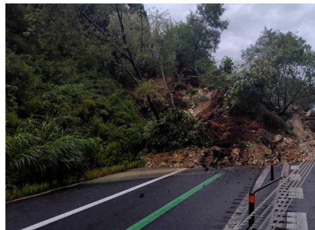
令和7年8月 秋田県北秋田市 日本海沿岸東北自動車道
