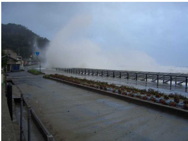
令和6年8月 山形県鶴岡市 国道7号
