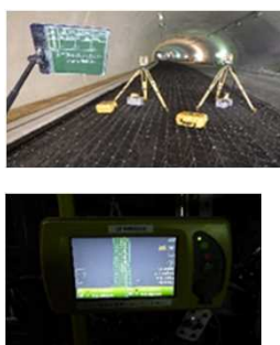
トータルステーションによるコンクリート打設
