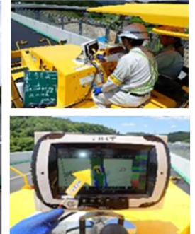
タイヤローラ転圧回数をヒートマップで確認
