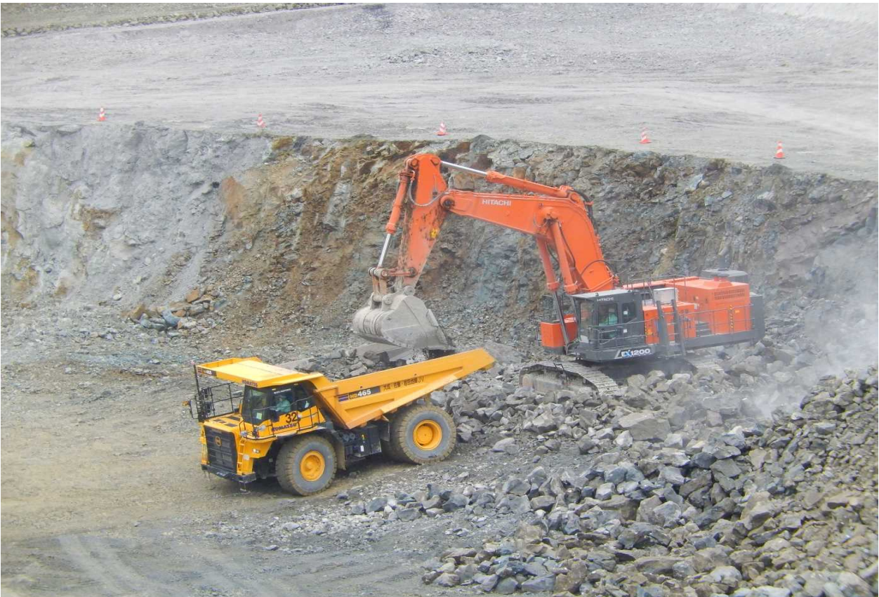
原石山展望台です(発破作業後の運搬状況です)
