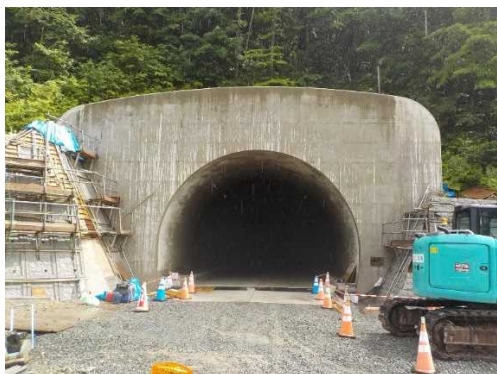
▲新しいトンネル
