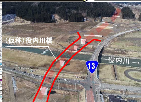
▲令和2年3月の工事進捗状況
