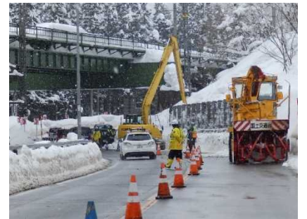
▲雪崩予防作業による片側交通規制
