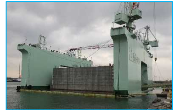
→ 防波堤として使用する『ケーソン※』の製作状況
