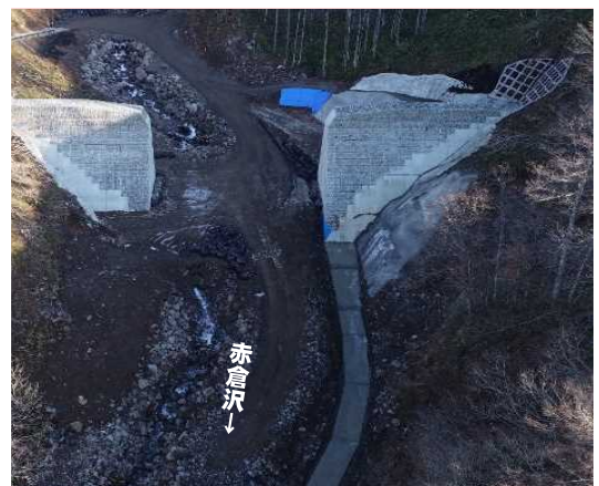
施工状況(R1)
