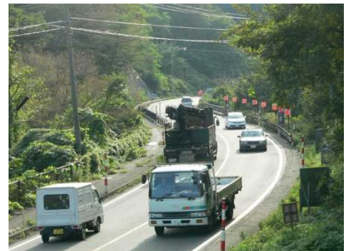
▲国道7号の線形不良箇所
