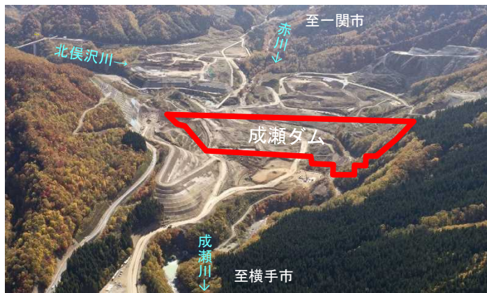
[下流側から望むダムサイト施工状況]
