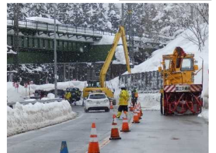
▲雪崩予防作業による片側交通規制
