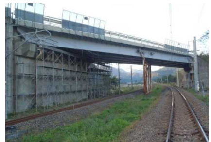
▲白沢跨線橋全景
