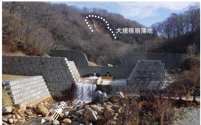
施工状況(H30)
