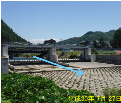
頭首工下流の状況
