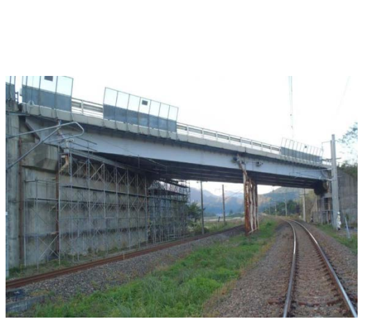
▲白沢跨線橋全景
