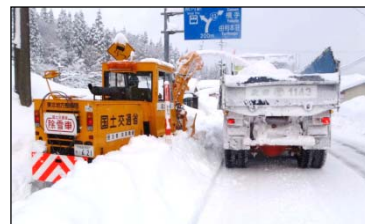
▲道路幅員が狭いため、通行を規制しての除雪
