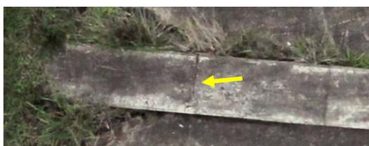
護岸工のクラック（幅 5mm）（高度 20m）
