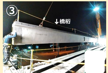
③ ↓ 橋桁 (微調整して所定の位置に設置)
