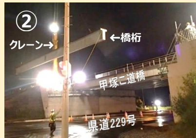
② クレーン→ ↑ ← 橋桁 甲塚こ道橋 県道229号 (400 t 吊りクレーンで橋桁を吊り上げて移動)
