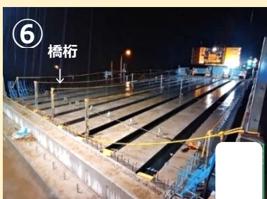
⑥ 橋桁 (架設が無事完了しました)
