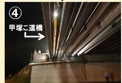
④ 甲塚こ道橋 ↑ (県道229号から甲塚こ道橋を見上げた状況)
