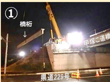
① 橋桁 ↓ (工場で製作したコンクリート製橋桁を搬入)
