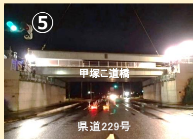
⑤ 甲塚こ道橋 県道229号 (県道229号から見た状況)
