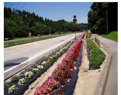
愛護団体『三阪小学校交通安全母の会・中三坂分会』による花壇の整備状況（国道49号）
