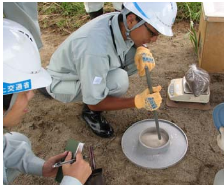
坂野辺地区堤防強化工事にて品質管理の体験
