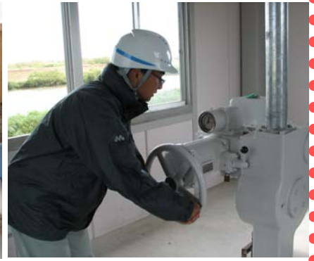
試田樋管にてゲートの手動操作体験
