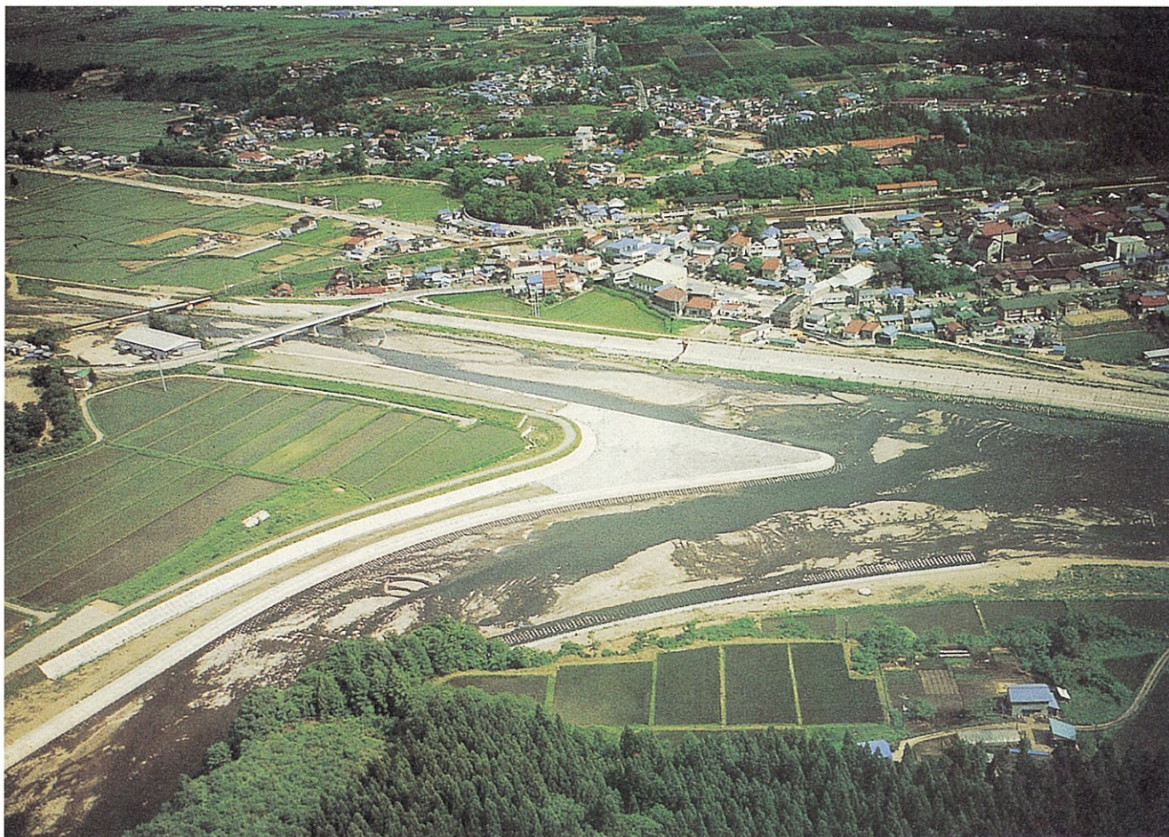
▲昭和54年 完成、真室川、金山川合流地点
