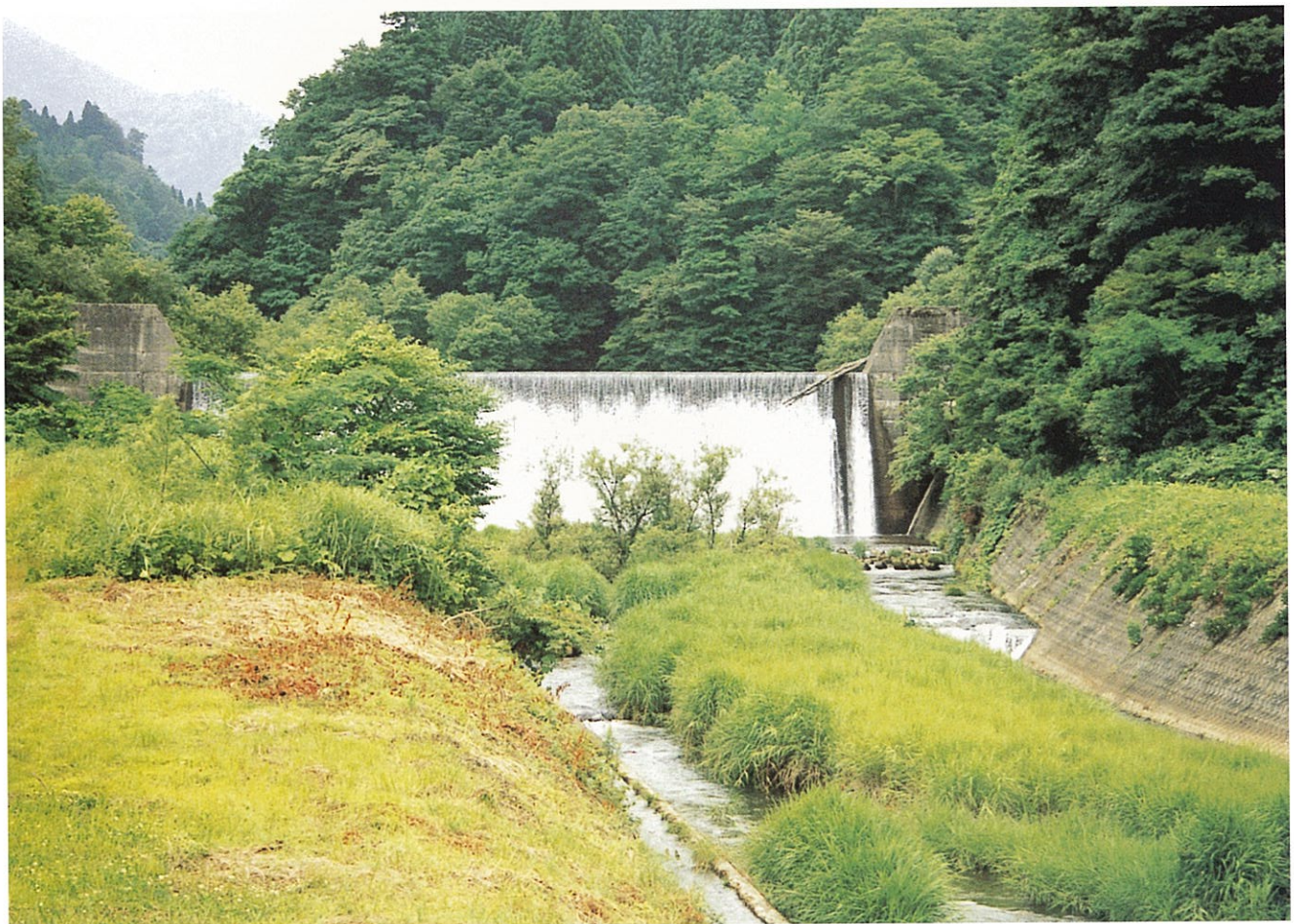
▲平成12年 現在の 上小又砂防ダム
