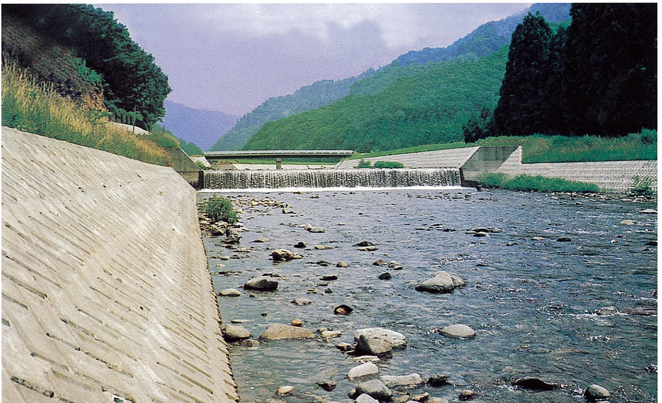
▲昭和54年完成、塩根川地区護岸工事
