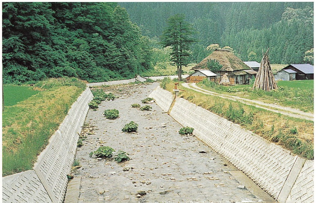
▶昭和54年完成 中ノ股地区 (4年後)
