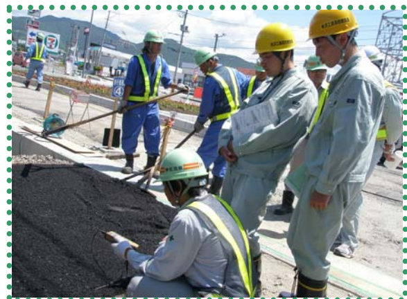
アスファルトの表面温度測定中 （180℃、炎天下の作業は大変です。）
