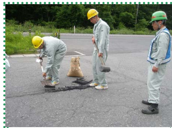
常温合材（アスファルト）で路面補修
