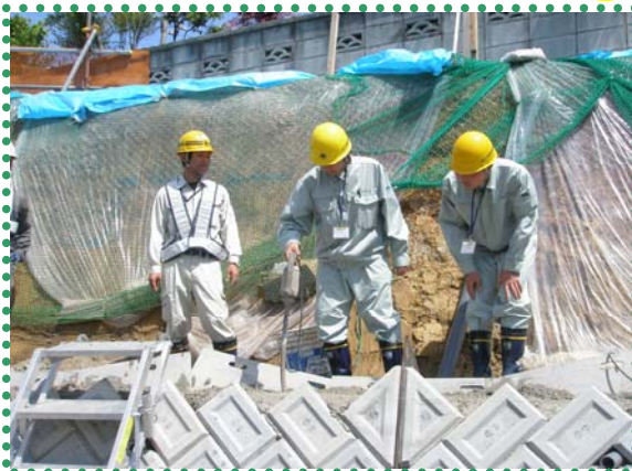
コンクリートの締固め作業 （空気を抜いています。）
