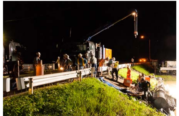
夜通しの作業の様子
