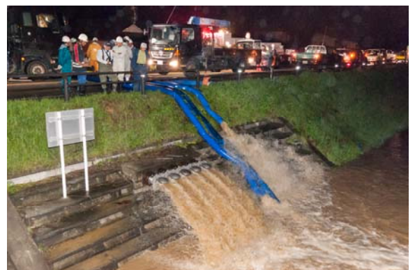
内水排除作業の様子
