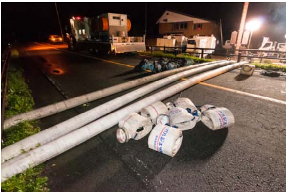
国道47号を排水ホースが横断
