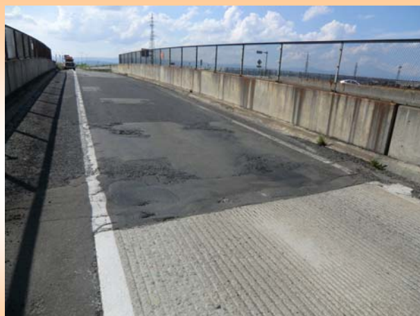
鳥越跨線橋下り（JR線路上空付近）
