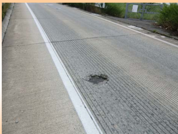
鳥越跨線橋下り（入口付近）
