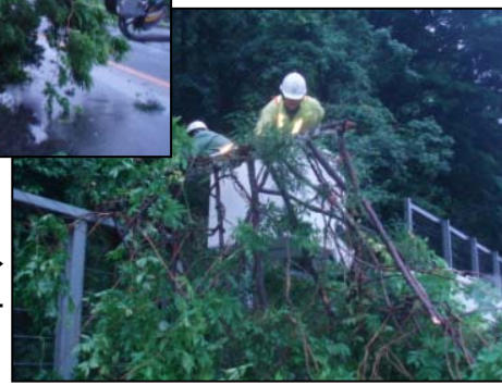
→ 復旧作業の様子
