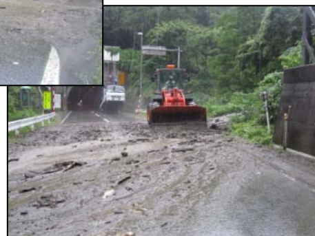
→ 復旧作業の様子
