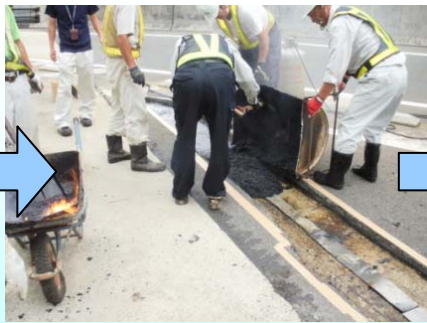
新しいアスファルト合材を舗設します
