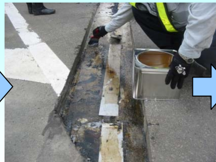
埋設された継ぎ手の上面にプライマー(接着剤)を塗布します
