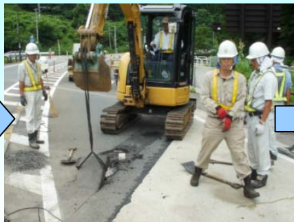
傷んだ舗装を取り除きます
