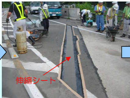
ひび割れを防ぐために衝撃を吸収する伸縮シートをかぶせます
