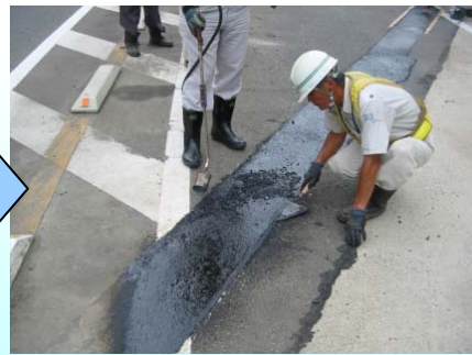
再びアスファルト合材を敷きならして完了です
