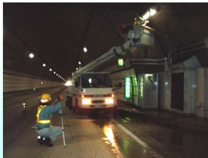
古くなった照明灯は交換します
