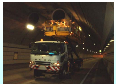
ジェットファンの点検も行いました
