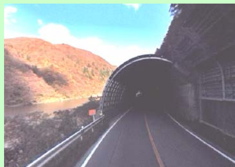
高屋スノーシェルター(酒田側)
