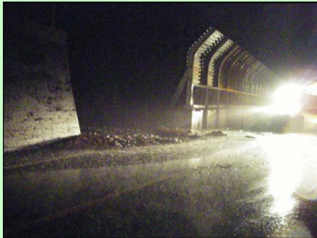
④ 土砂が道路に流出 148.6kp 外川
