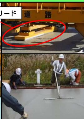
スクリード（仕上げコテ）を進行方向に対して前後に動かしながら、コンクリート舗装表面の最終仕上げを行う機械です。この後に、人力による粗面仕上げを行います。（機械仕上げのままだと表面がつるつるで危険なので。）
