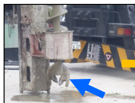
オーガで掘削
