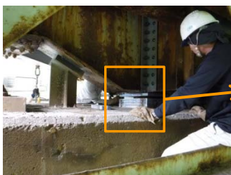
①ジャッキで持ち上げ、古い支承を取り除きます
