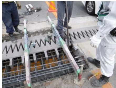
④新しい伸縮装置を設置します
