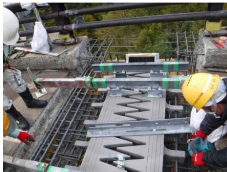
④新しい伸縮装置を設置します
