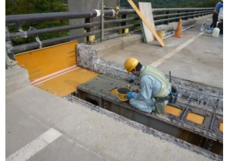
③新しい伸縮装置設置前の錆防止処理中
