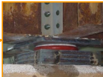
①ジャッキで持ち上げ、古い支承を取り除きます
