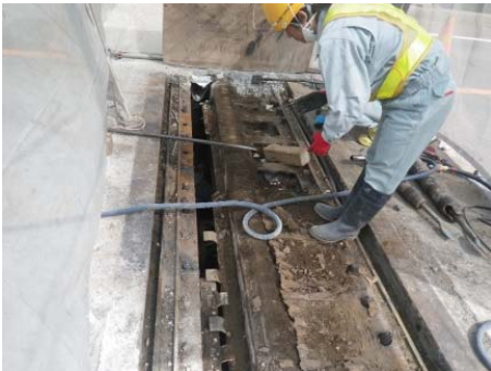
①古い伸縮装置を撤去します
