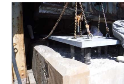
②持ち上げたら新しい支承を設置する
