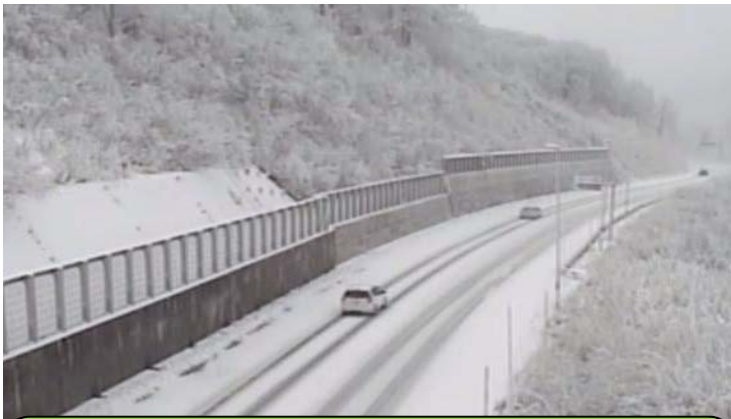
11月27日午前9時頃の西川町志津地内の路面状況です。 この状態での夏タイヤでの走行は非常に危険です！ また、山形県道路交通規則にも違反します。
