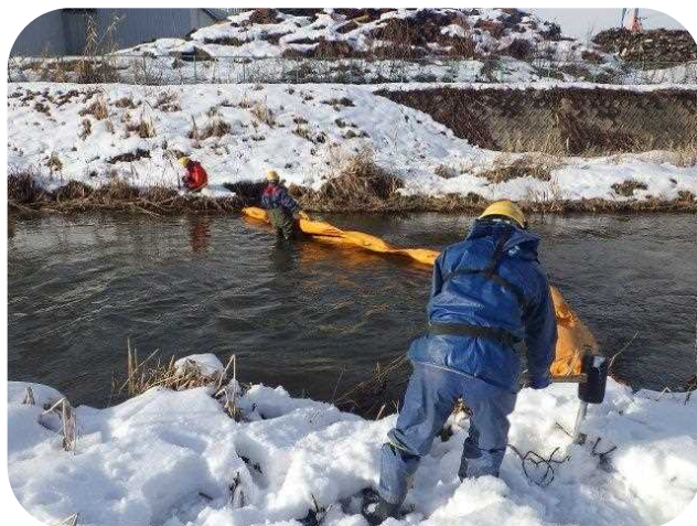
▲ オイルフェンスを設置している様子。下流への油の拡散を防止するため、オイルフェンスを設置し、回収する必要があります。
