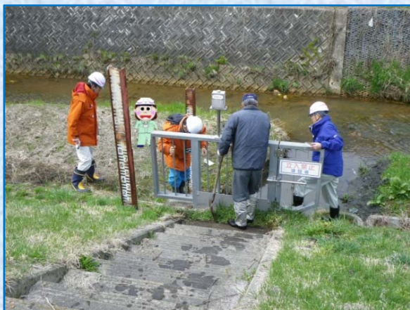
樋門や周囲に異常や 損傷等がないかの確認
