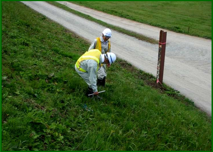
貫入棒を入れて 堤防内部の様子をチェック
