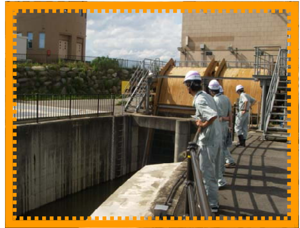
排水ポンプの実働を見学。
