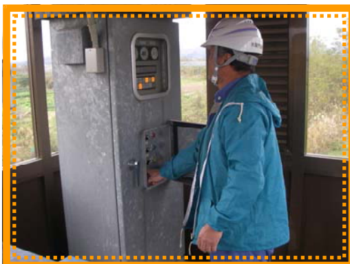
ゲート操作の様子
