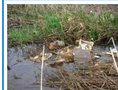
左岸 No.70-50 さくら大橋下流 古川 古川内へゴミ堆積 (空き缶・ペットボトル) (発泡スチロール) 4月24日確認 ※5月2日投棄物の回収確認
