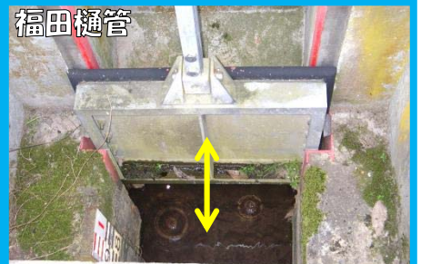
ゲートの開閉に異常がないかと、開閉後の状況も確認しました。
