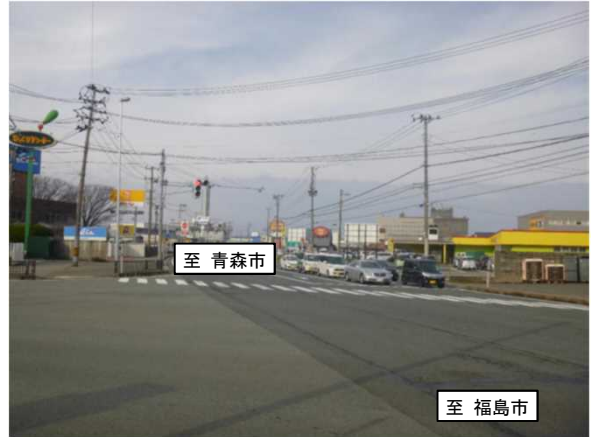
▲ 国道13号の電柱状況
