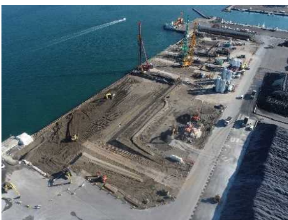
▲岸壁の整備状況
