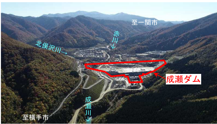
[下流側から望むダムサイト施工状況]
