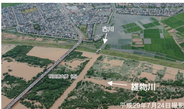
▲平成29年出水による被害状況
