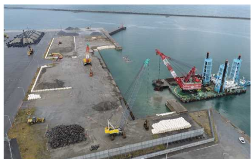
▲岸壁の整備状況
