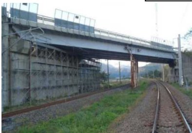
▲白沢跨線橋全景
