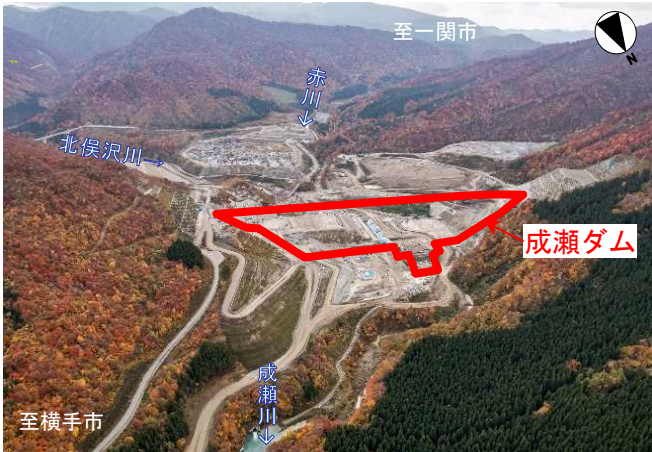
[下流側から望むダムサイト施工状況]
