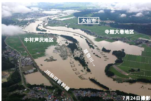
【H29年7月出水浸水状況】
