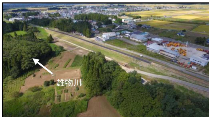
堤防完成 (令和元年9月25日撮影)
