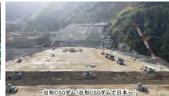
台形CSGダム(台形CSGダムで日本一)
