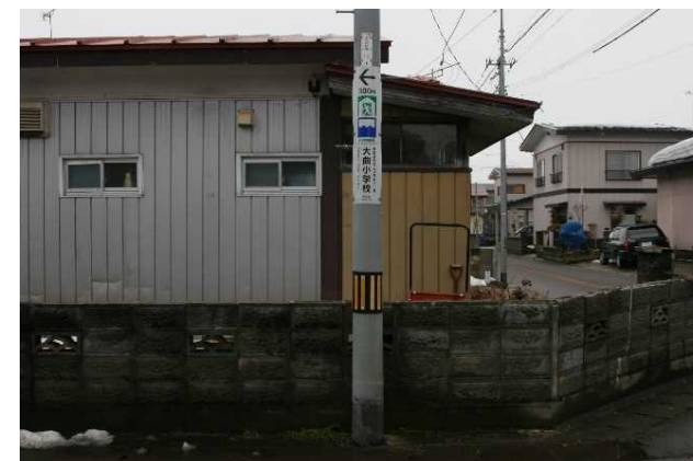
電柱に設置した例（大仙市）
