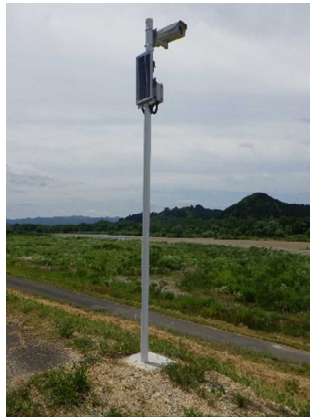
簡易型河川監視カメラ設置状況
