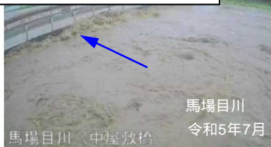
出水による被害状況
