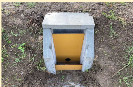
田んぼダムに対応した田面排水柵・水位調整板のイメージ
