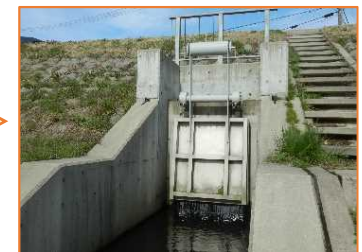
整備後（フラップゲート設置）
