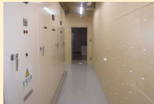
屋内に電気室を設置
