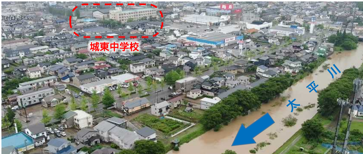
周辺一体が浸水した城東中学校付近
