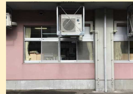
エアコン室外機を吊り下げ設置
