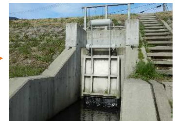
整備後（フラップゲート設置）
