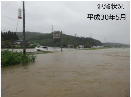
出水による被害状況
