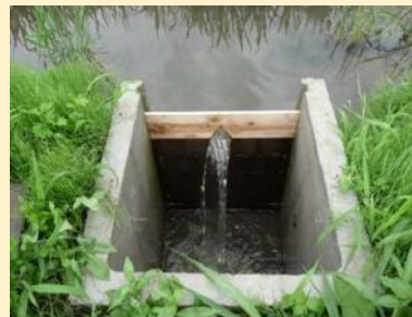
田んぼダムに対応した田面排水柵・水位調整板のイメージ
