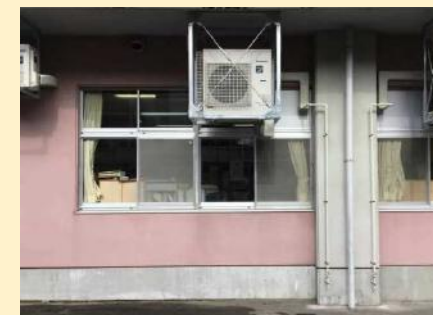
エアコン室外機を吊り下げ設置
