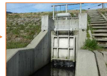
整備後（フラップゲート設置）
