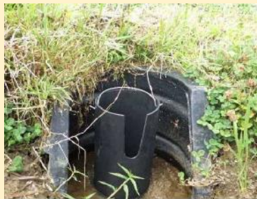
田んぼダムに対応した田面排水柵・水位調整板のイメージ
