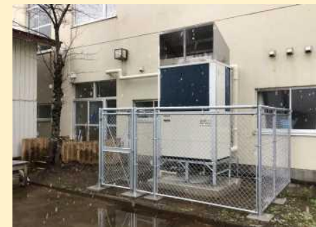
空調設備の基礎嵩上げ
