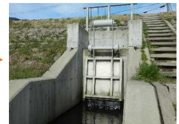
整備後（フラップゲート設置）
