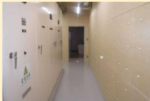
屋内に電気室を設置
