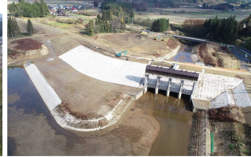
大沢川樋門整備状況
