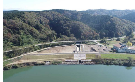
戸草沢地区 堤防・排水樋門整備状況
