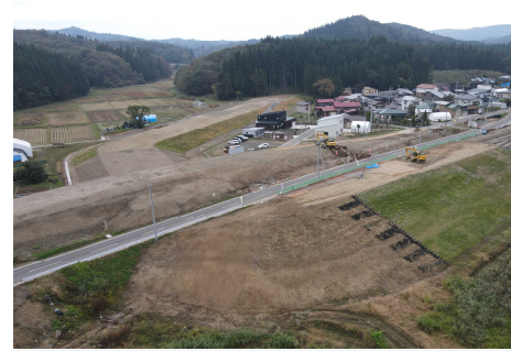
岩瀬湯野沢地区堤防整備状況
