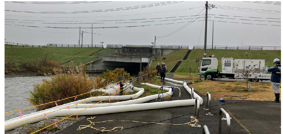
ポンプ車による排水訓練
