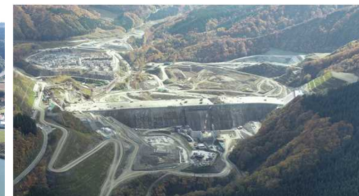
成瀬ダム 本体工事進捗状況 (令和5年10月31日撮影)
