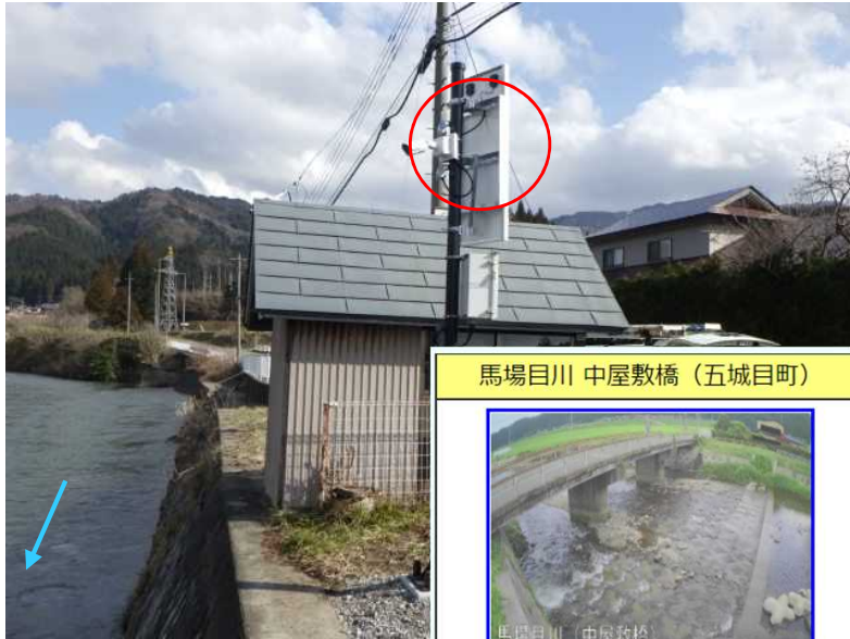
河川監視カメラ設置状況 （馬場目川 五城目町馬場目中屋敷地区 中屋敷橋）
