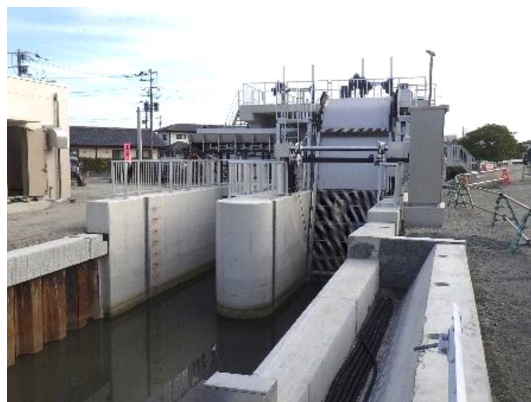
雨水ポンプ場の整備
