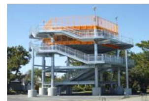
津波避難タワー
