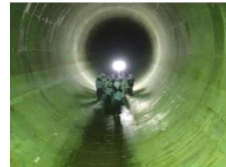
雨水貯留管の整備
