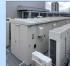
電気設備の設置場所の嵩上げ
