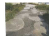
農道の窪みの補修
