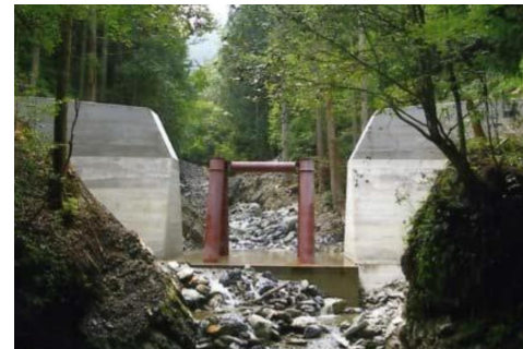
流木捕捉式治山ダムの整備
