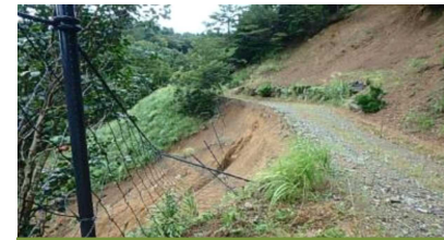
被災した森林作業道の復旧
